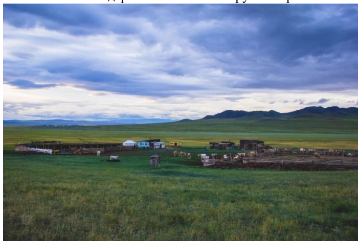
Рис. 3. Общий вид построек и сооружений чабанской стоянки
